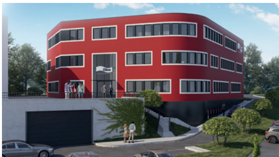
Das im Jahr 2022 fertiggestellte neue Firmengebäude
